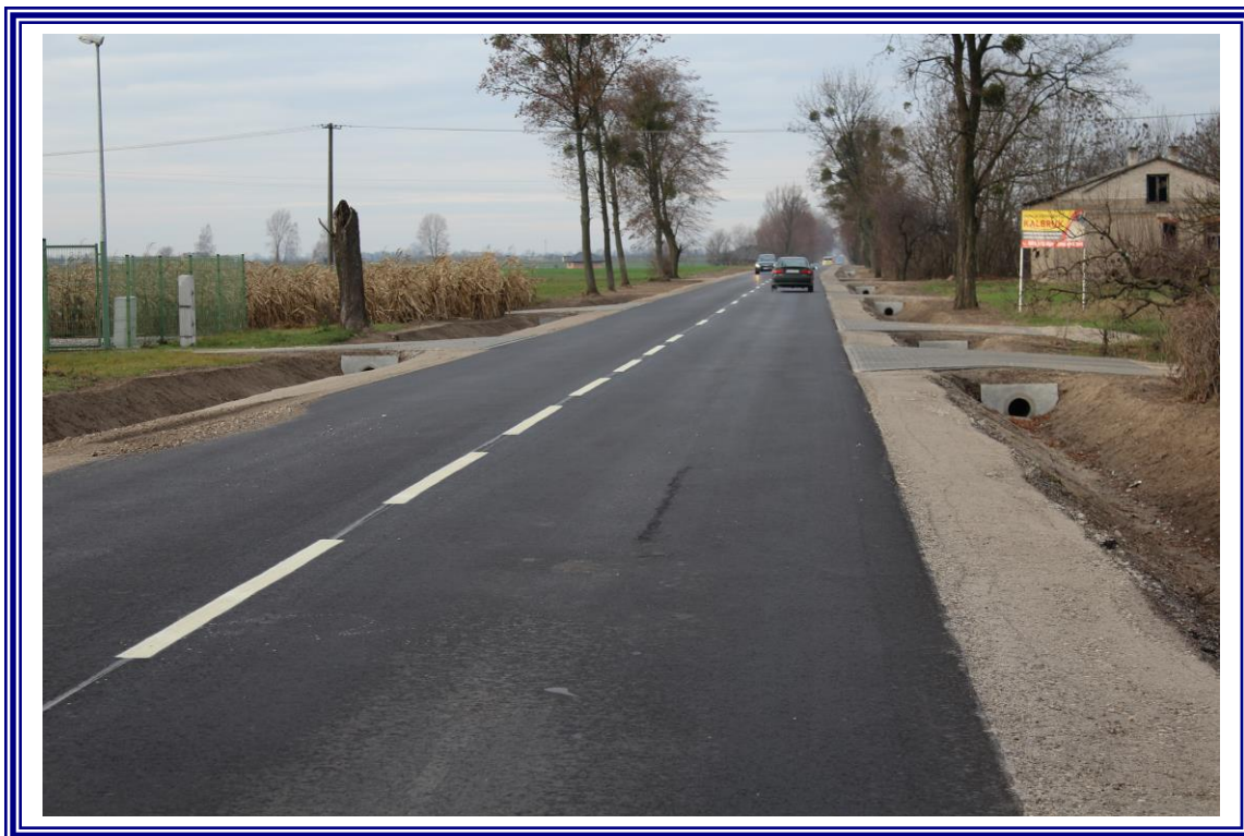
„Przebudowa drogi powiatowej Nr 2605C Stara Wieś – Nieszawa – na odcinku od km 5+888 do 7+544 – etap II”
