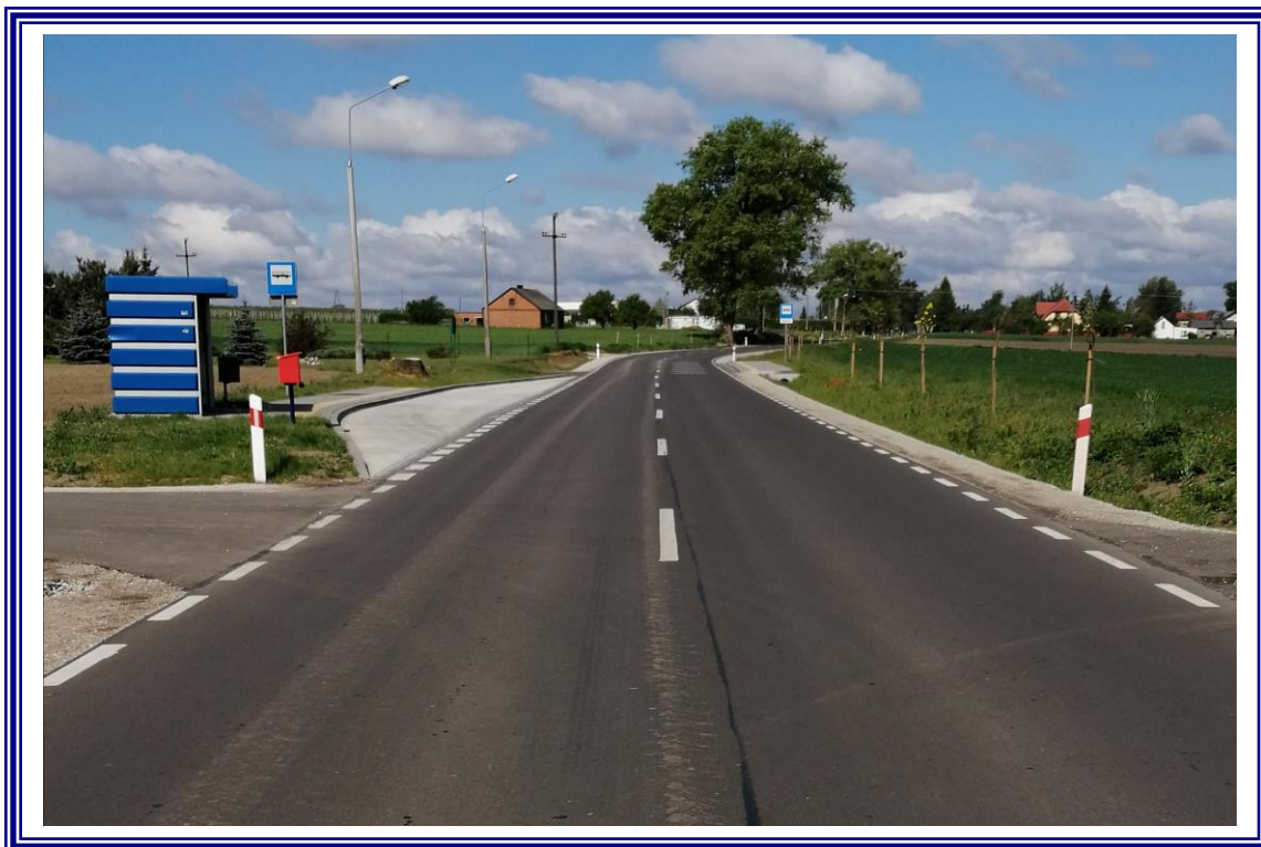
„Przebudowa drogi powiatowej Nr 2528C Żyroślawice – Przybranowo wraz z przebudową mostu dł. 2,80 km od km 5+950 do km 8+750”- etap III”
