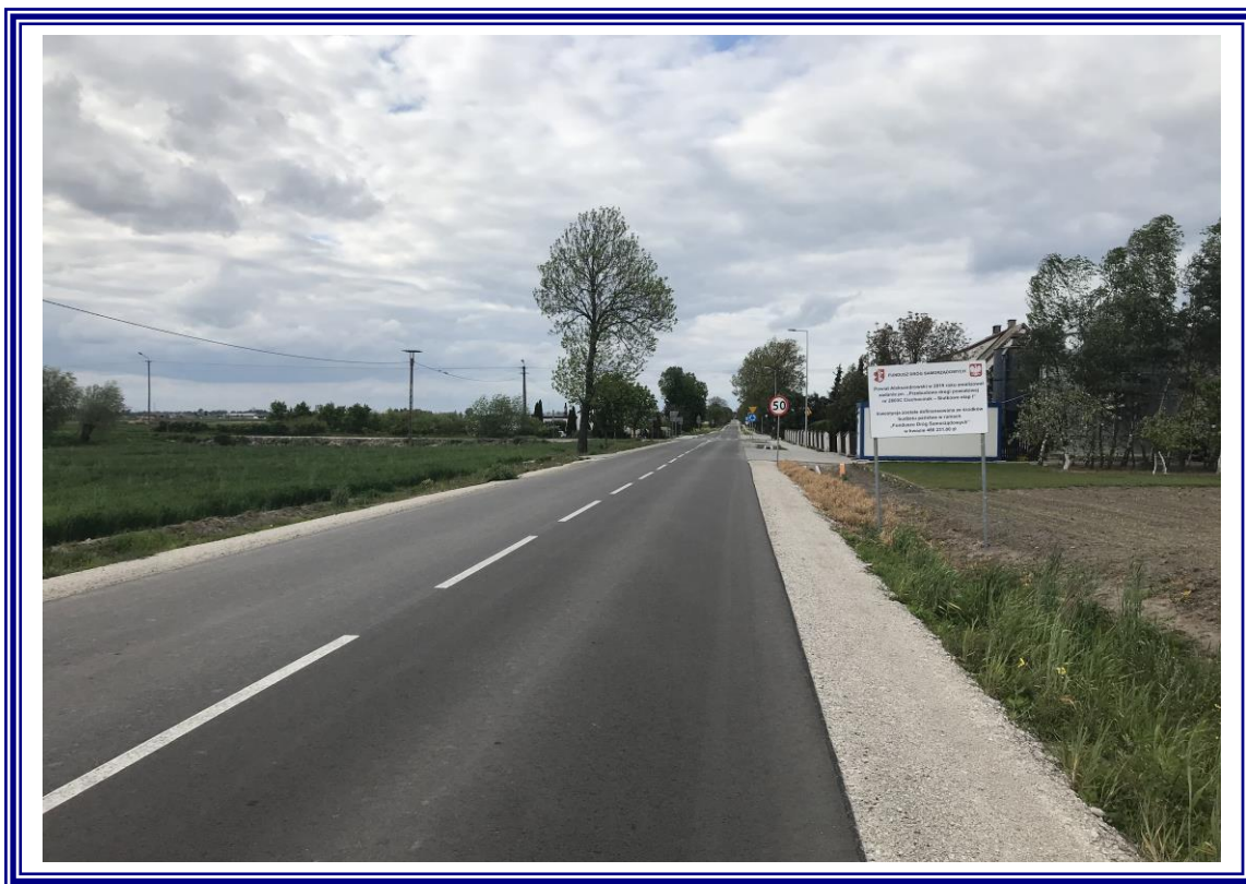
„Przebudowa drogi powiatowej Nr 2603C Ciechocinek – Siutkowo wraz z przepustami – etap I – odcinek o długości 0,926 km”.
