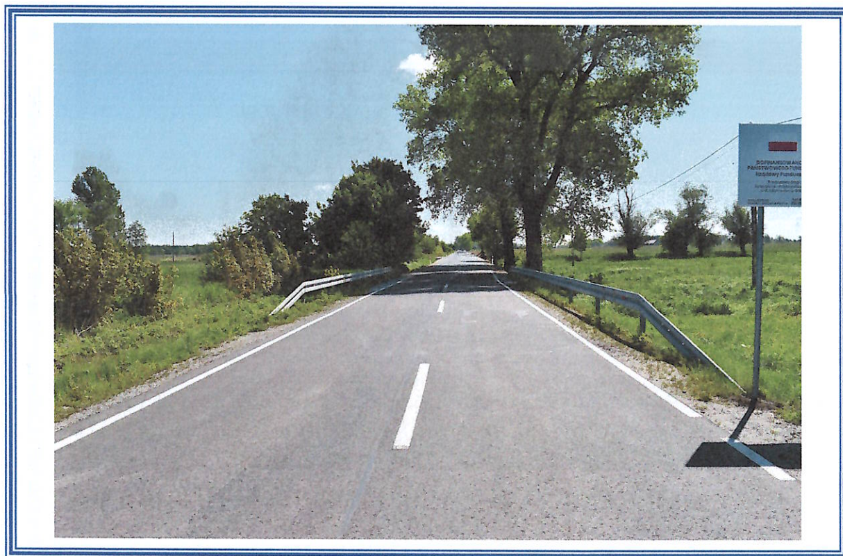
Przebudowa drogi powiatowej nr 2528C Żyrosławice – Przybranowo wraz z przebudową mostu o dł. 2,80 km od km 5+950 do km 8+750 – etap IV odcinek od km 7+846 do km 8+620
