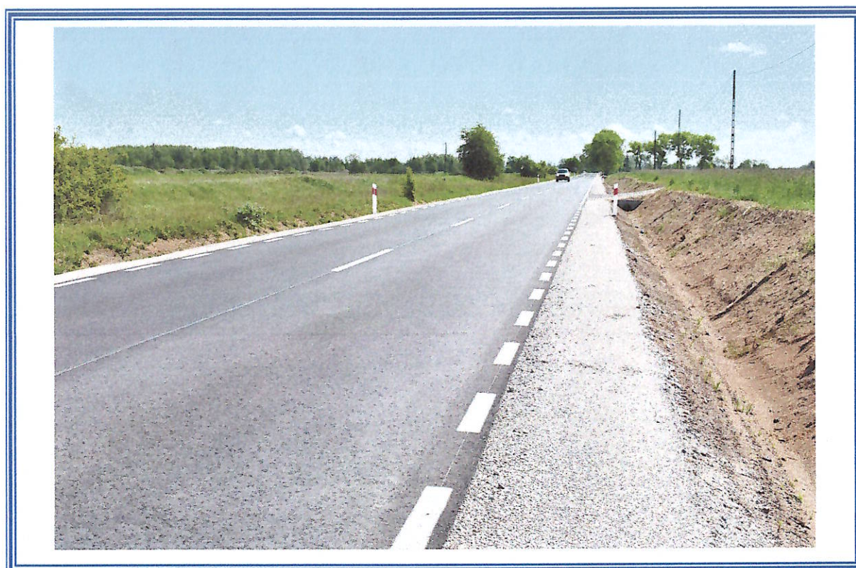
Przebudowa drogi powiatowej nr 2528C Żyroślawice – Przybranowo wraz z przebudową mostu o dł. 2,80 km od km 5+950 do km 8+750 – etap IV odcinek od km 7+846 do km 8+620
