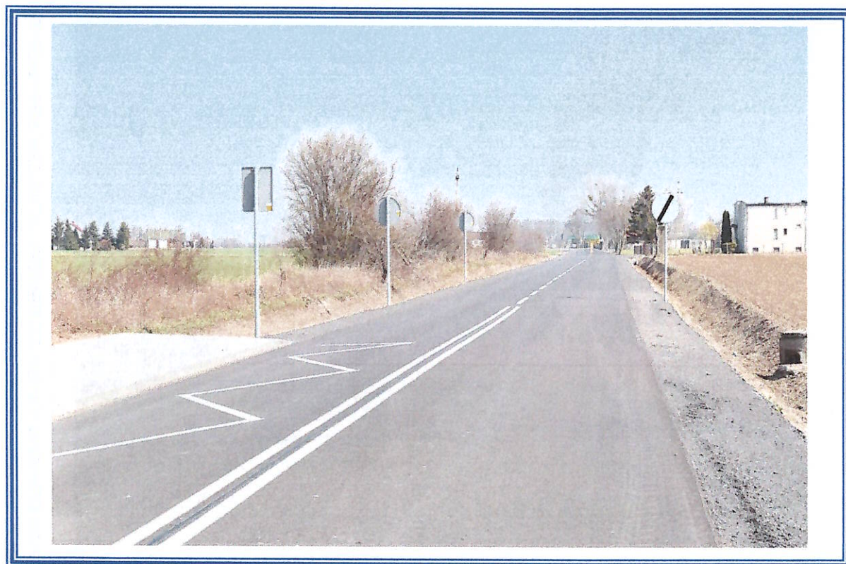
Przebudowa drogi powiatowej nr 2612C Nieszawa – Ujma Duża na odcinku od km 10+100,00 do km 12+173,50 – etap I
