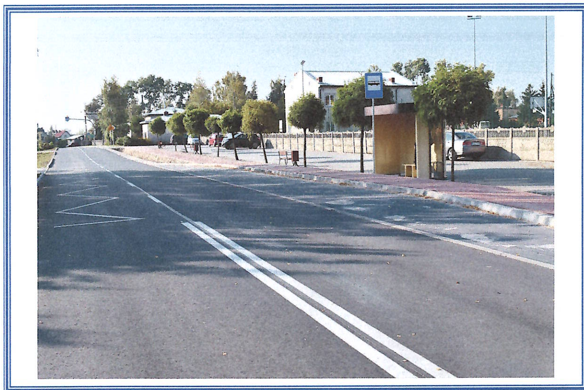
Przebudowa drogi powiatowej Nr 2603C Ciechocinek – Siutkowo wraz z przepustami zadanie nr 1 etap III – od km 12+471 do km 13+350
