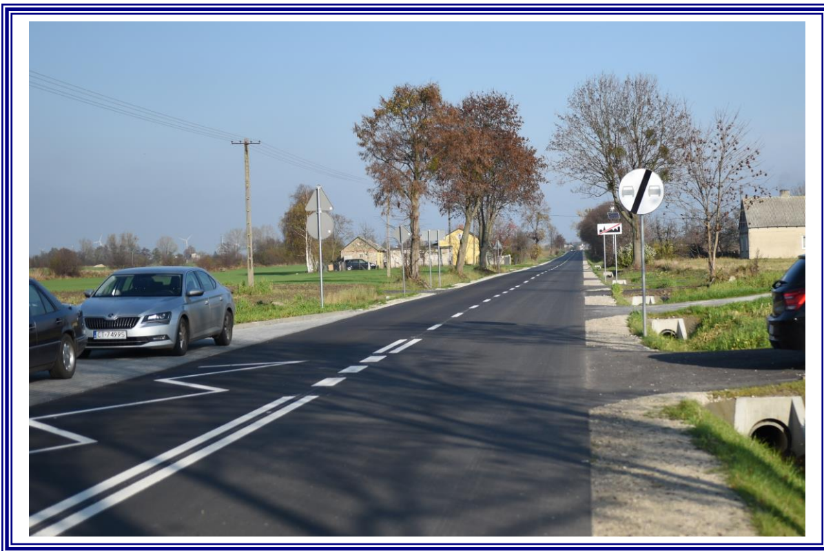
Przebudowa drogi powiatowej Nr 2612C Nieszawa – Ujma Duża na odcinku od km 5+301,50 do km 10+100,00 Etap II o długości odc. 4,7985 km.
