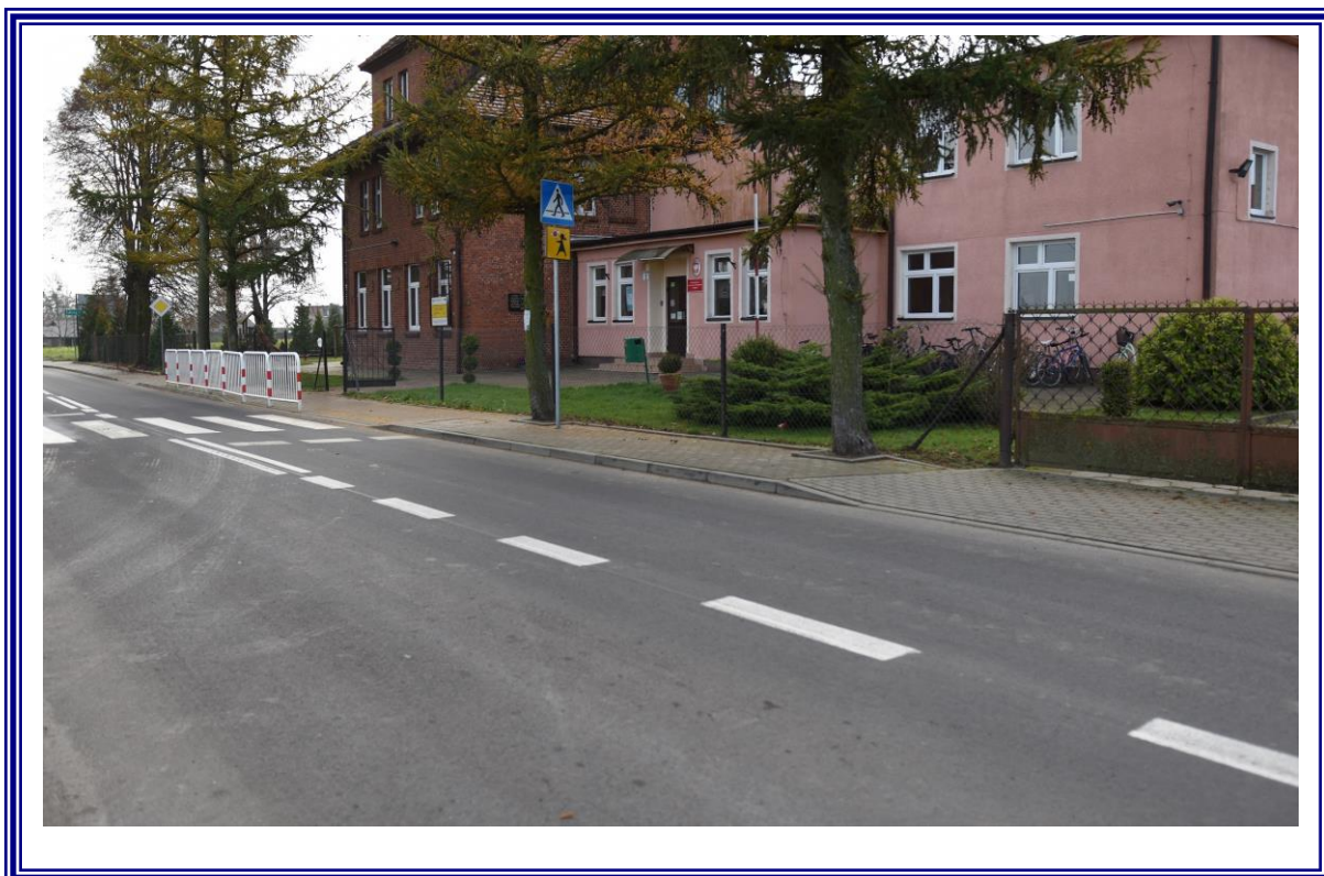
Przebudowa drogi powiatowej nr 2528C Żyroślawice – Przybranowo na odcinku od km 0+000 do km 2+727 o długości odc. 2,727 km.
