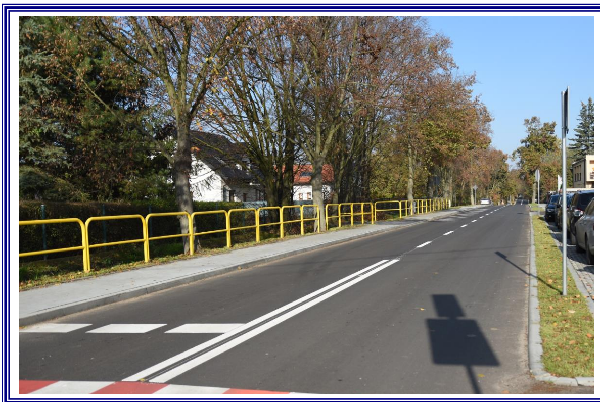
Przebudowa drogi powiatowej Nr 2603C Ciechocinek – Siutkowo na odcinku od km 10+420 do km 11+88 o długości odc. 1,388 km.
